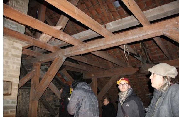
Abb. 8: Begutachtung des sanierten Dachstuhls
