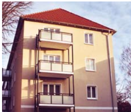
Abb.1: So sollte man es nicht machen: Auswirkungen von Schattenwürfen und direkter Sonneneinstrahlung auf Thermografieaufnahmen
