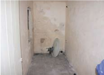
Abb. 7: Durchfeuchtete Bereiche einer Kelleraußenwand, die Form des Durchfeuchtungs horizontes ist bereits visuell wahrnehmbar.
